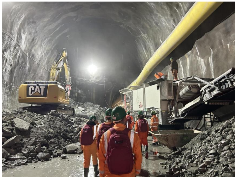
Abbildung 5: Besichtigung des Gotthardtunnels
