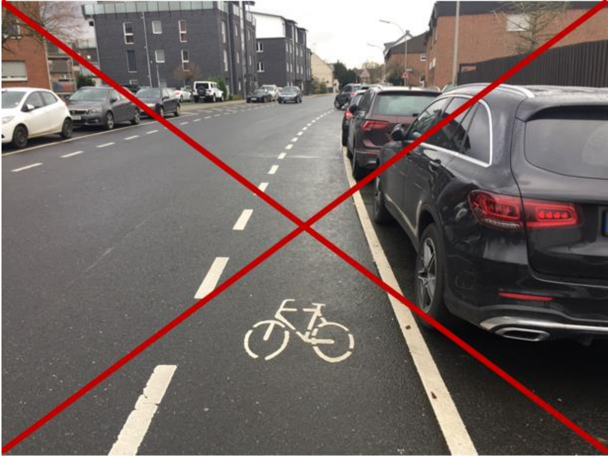
Abbildung 12: Schutzstreifenlösung mit Gefahr von „dooring“-Unfällen
